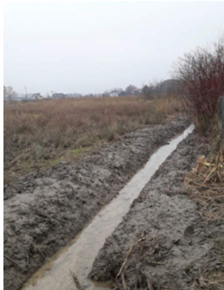
Rów melioracyjny R-A w rejonie ul. Letniej bocznej (Fot. Spółka Wodna)
