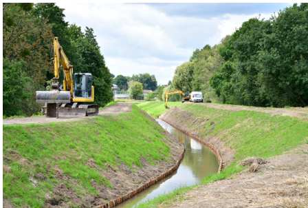
Łączna wartość inwestycji na terenie gminy to ok. 2,5 mln zł (Fot. UG)
