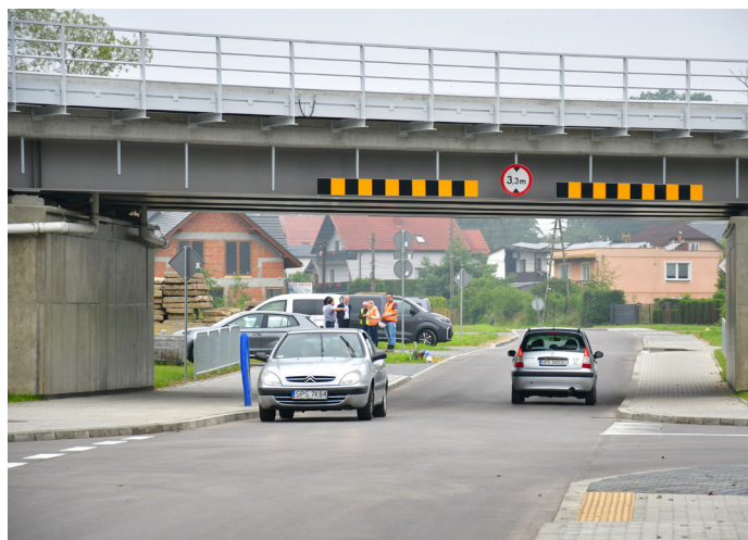
Tunel na ul. Głównej jest już przejezdny (Fot. UG)
